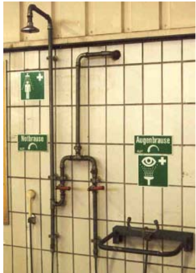
Abbildung 5: Zu einer Batterieladestation gehört eine Notdusche und eine Augenspülstation (Augenbrause)
