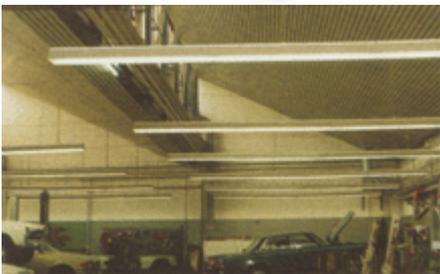
**Bild 6-40:** Schallabsorbierend gestaltete Decke in einem Karosserie-Instandsetzungsbetrieb
