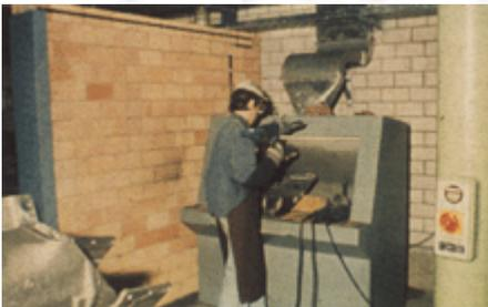
**Bild 6-33: Trennwände aus Lochziegeln mit waagrecht liegenden Löchern zwischen Gussputz-Arbeitsplätzen**
