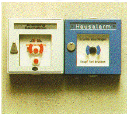
Bild 12-8: Druckknopfmelder für Hausalarm und zur Ansteuerung von Rauch- und Wärmeabzügen
