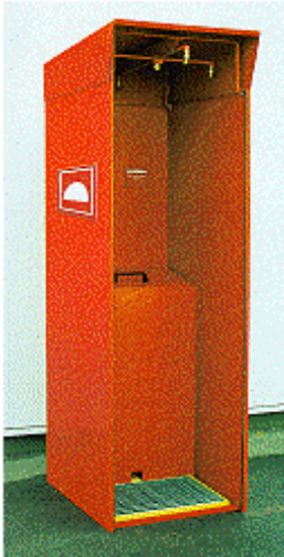
Bild 12-35: Löschkabine zur Selbsthilfe bei brennender Kleidung
