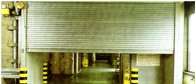
Bild 11-7: Selbstschließendes Feuerschutz-Rolltor
