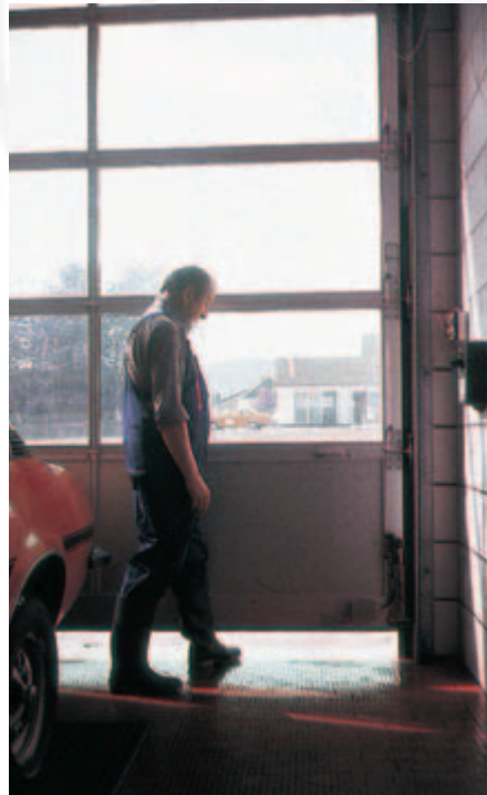
Bild 3-1: Kraftbetriebenes Hallentor mit Kontaktleiste an der unteren Schließkante
