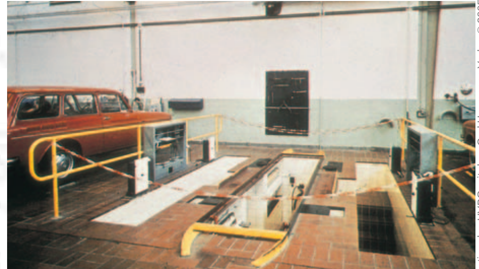
Bild 4-6: Durch Geländer und Ketten gesicherte Arbeitsöffnungen
