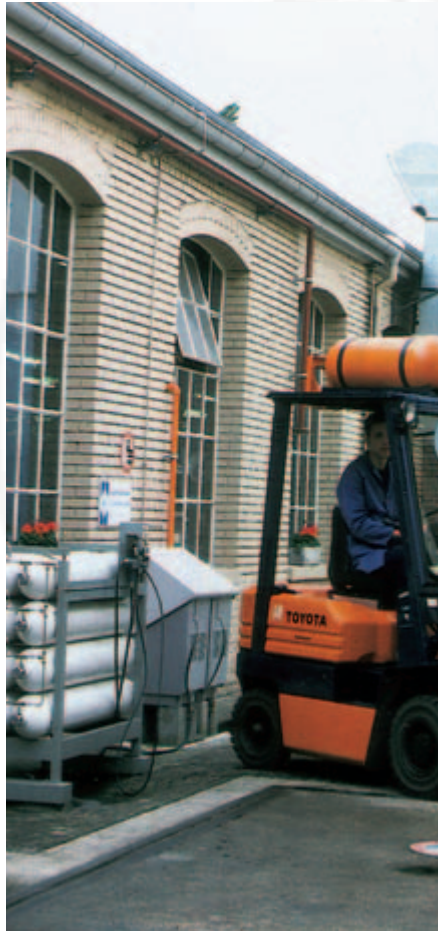
Bild 7-4: Innerbetriebliche Tankstelle für erdgasbetriebene Gabelstapler
