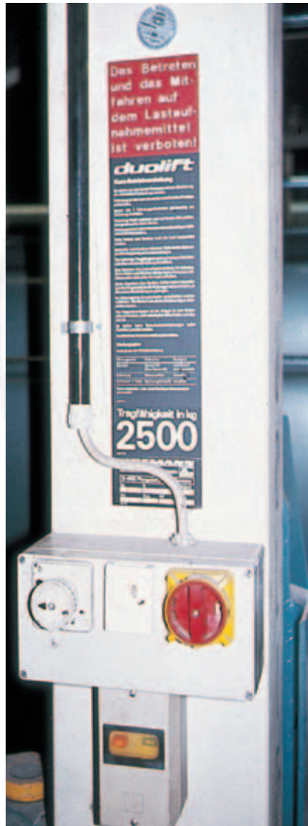
Bild 9-1: Abschließbarer Hauptschalter an einer Hebebühne als Sicherung gegen unbefugte Benutzung
