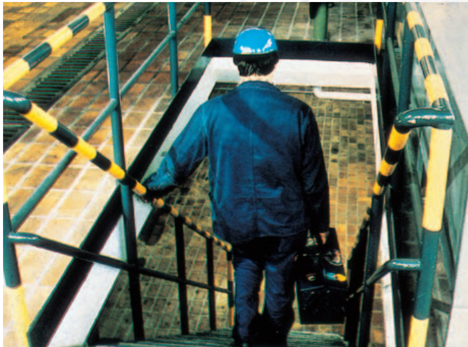
Bild 4-1: Sicherer Zugang zu einer Unterfluranlage
