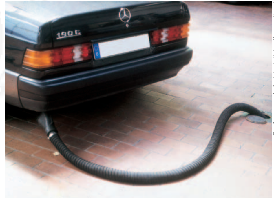
Bild 15-3: Abgasabsaugung mit Unterfluranlage
