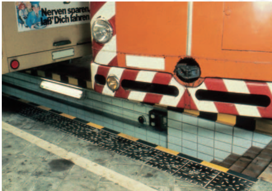
Bild 4-3: Durch Fahrzeug verstellter Ausgang einer Arbeitsgrube
