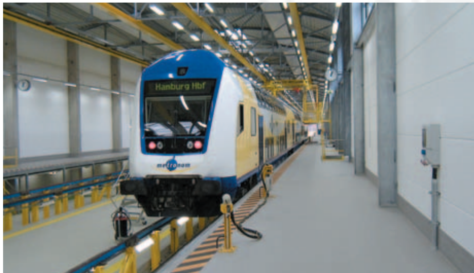
Bild 4-5: Arbeitsgrube in einer Bahnbetriebswerkstatt
